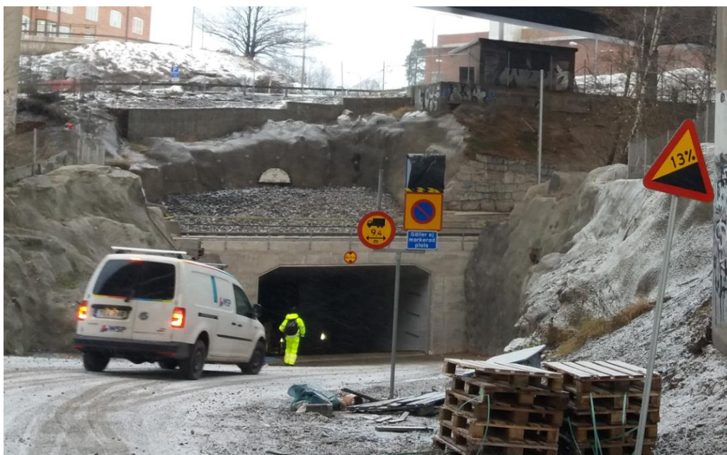
Figur 4. Fotografi taget under platsbesök 2016-12-02 som visar den befintliga tunnelinfarten till Citybanan vid Tomtebodan.
