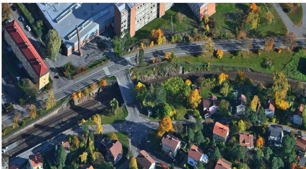
Figur 14. Befintlig bergskärning vid Odelbergsviadukten.
