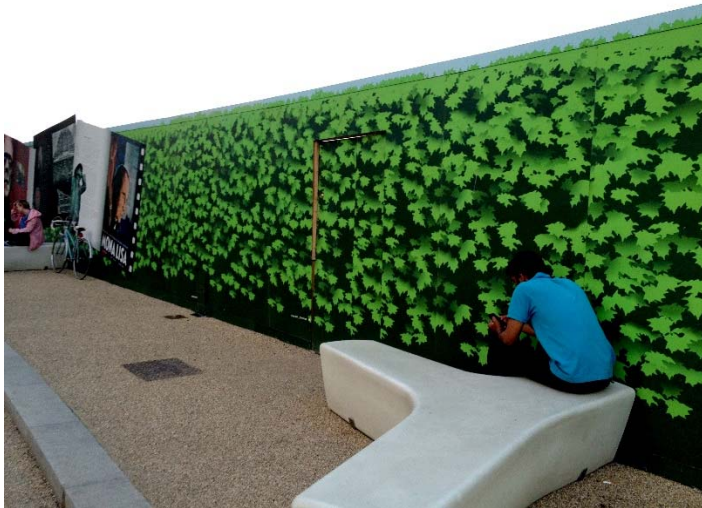
Figur 29. Exempel på byggavskärmning vid ombyggnad av Kings Cross, London.
