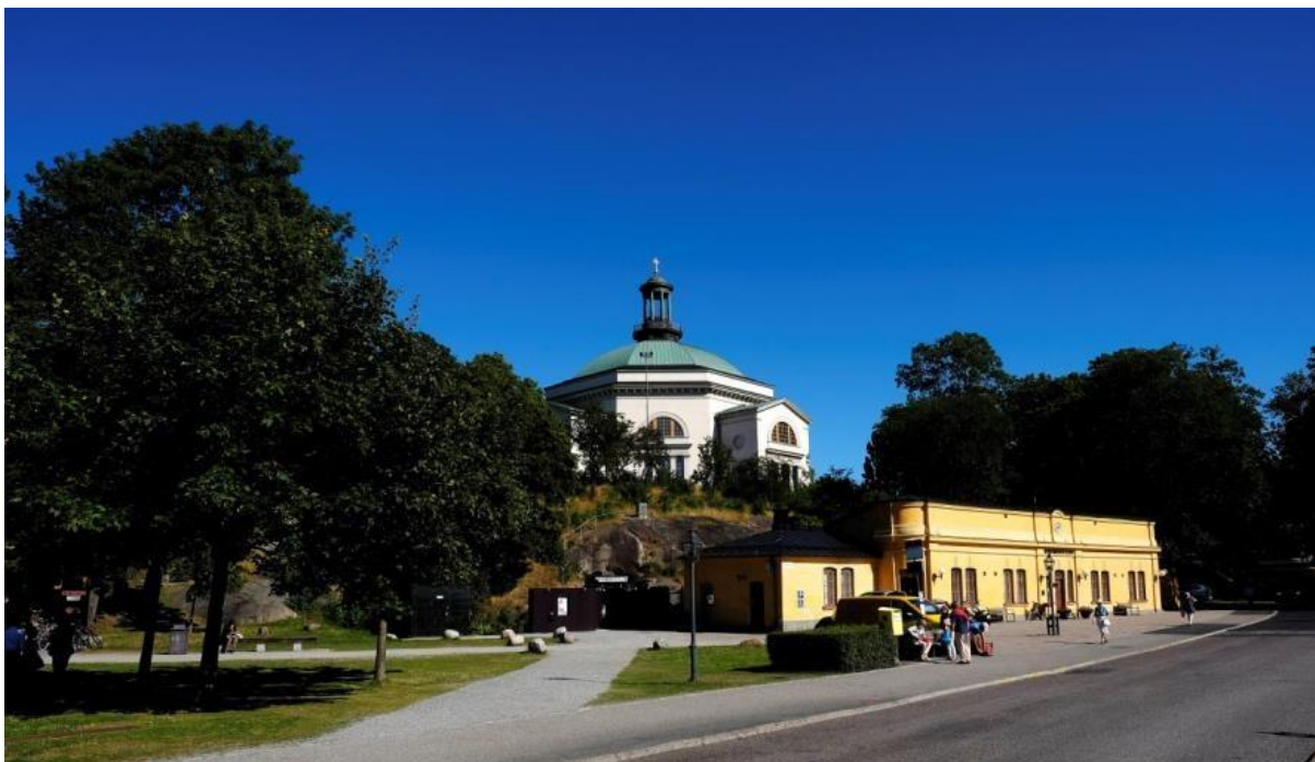
Figur 77 Exempel på landmärke, Skeppsholmskyrkan på Skeppsholmen
