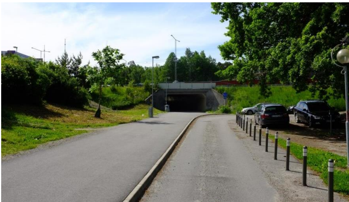
Figur 40 Exempel på gångstråk under Värmdöleden
