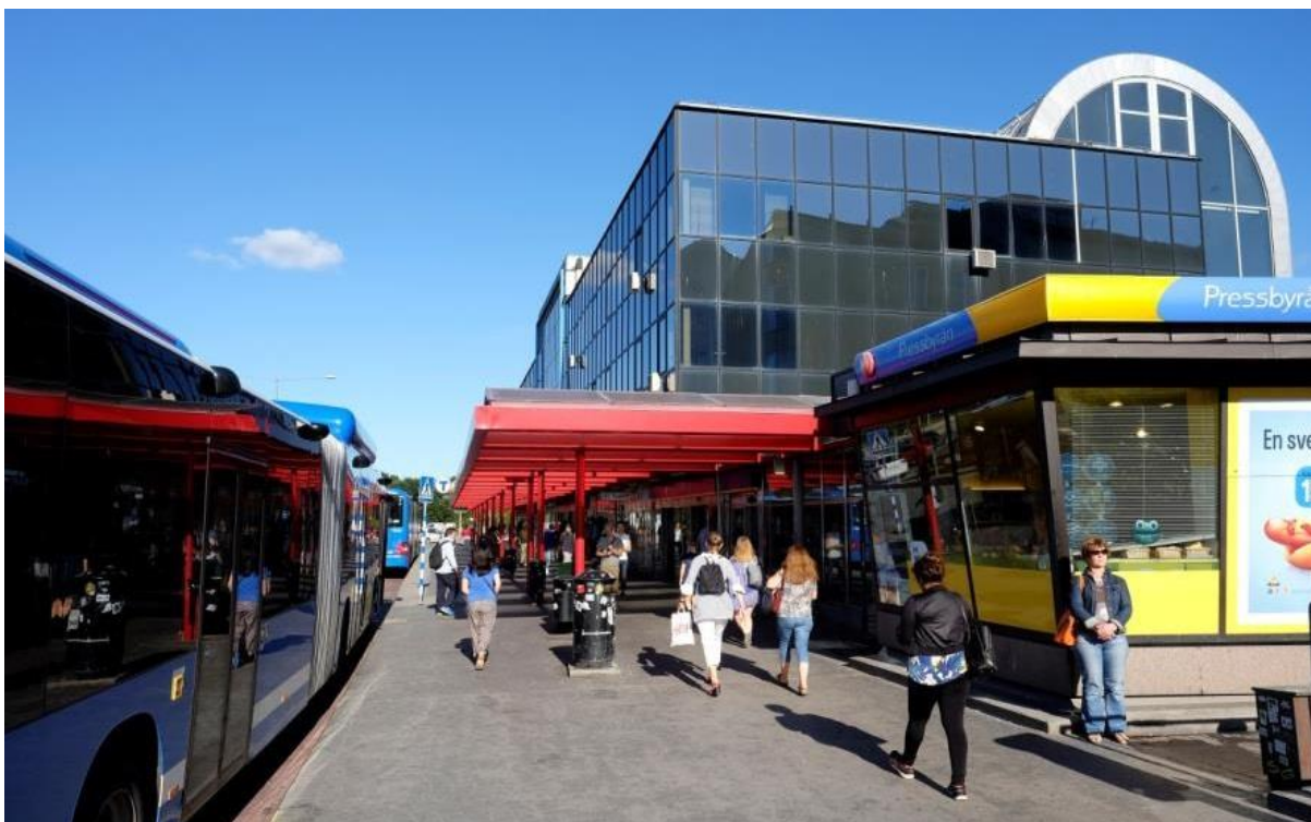
Figur 50 Exempel på landmärke, Gullmarsplans befintliga tunnelbanestation
