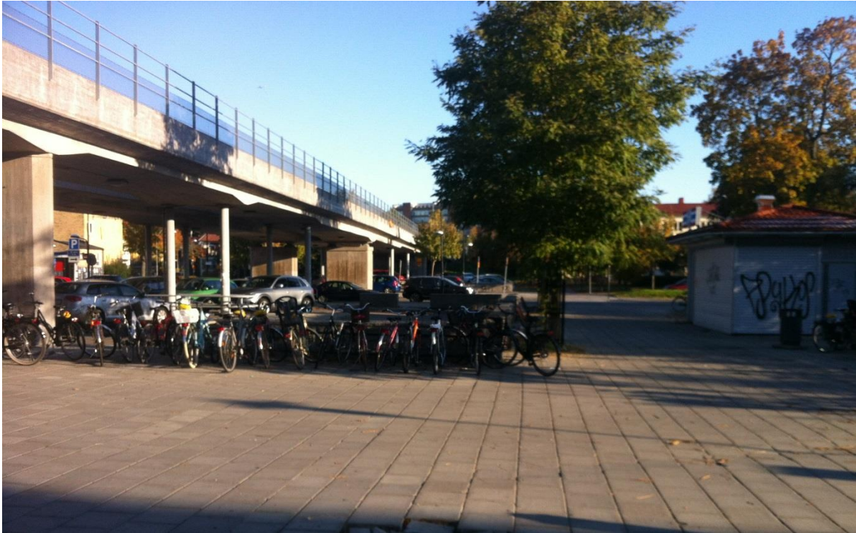
Figur 68 Den långa tunnelbanebron över dalstråket vid Sockenplan. Foto: Sweco
