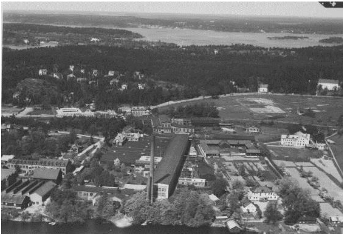
Figur 30 Järla industriområde 1936. I förgrunden syns den långa turbinhallen och strax bakom den det karaktäristiska gjuteriet. Saltsjöbanan ligger av strax norr om industribebyggelsen, medan vägen fortfarande har den gamla sträckningen och går i en vid båge runt ett öppet gårde. Till höger i bilden ligger Järla Gård, fortfarande med bevarade ekonomibyggnader och trädgård. I bergsslutningarna norr om vägen klättrar arbetarvillorna på bergsslutningarna. Ett flertal av dessa bevaras än i dag. Källa: Stockholms Länsmuseum
