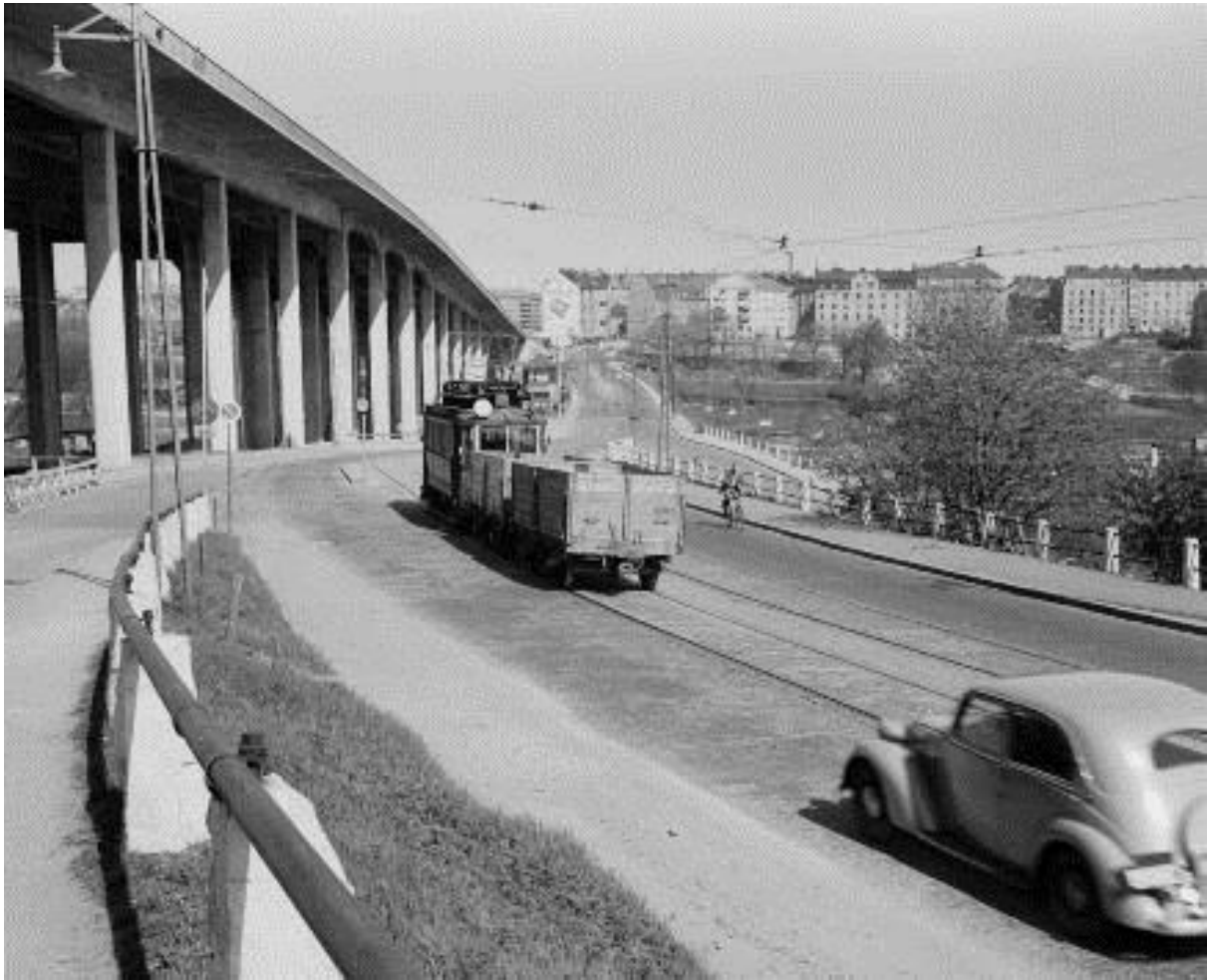
Figur 43 Vyn från 1950-talet visar olika generationer av vägar och broar. Göta landsväg följde näset mellan nuvarande Gullmarsplan och Södermalm i ungefär samma sträckning som Skansbrogatan, som framträder mitt i bilden bakom spårvagnen. Skansbacken, i förgrunden till vänster, utgjorde den gamla landsvägen till Dalarö. Fortsättningen av den gamla Göta Landsväg mot sydväst försvann i och med bygget av högbron Skanstullsbron. Hammarbybacken syns till höger i bilden. Idag ansluts Skansbacken till Hammarbybacken genom en trappväg. Foto: Stockholmskällan
