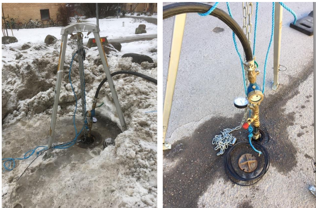
Figur 2. Pågående infiltration i brunn 17W161BR (vänster) och 18W008BR (höger).
