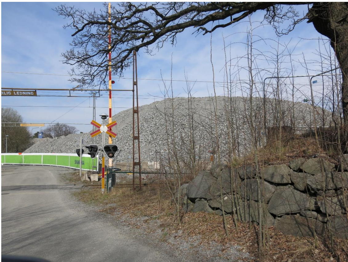
Figur 2 Exempel på bullervall vid krossanläggning
