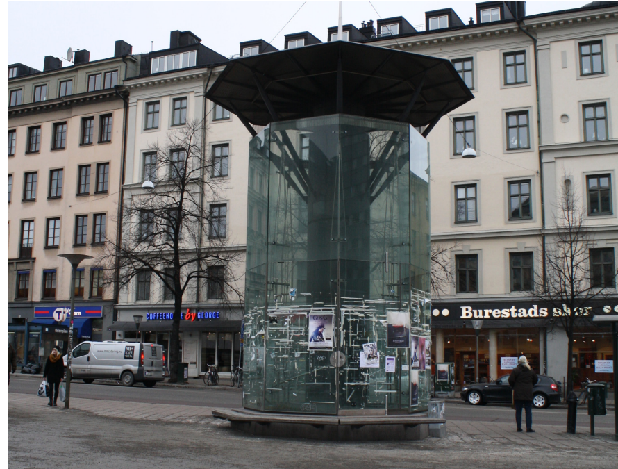
Exempel på ventilationstorn för brandgas
