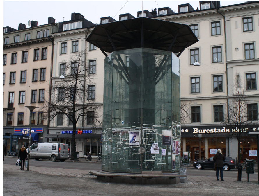
Exempel på ventilationstorn för brandgas
