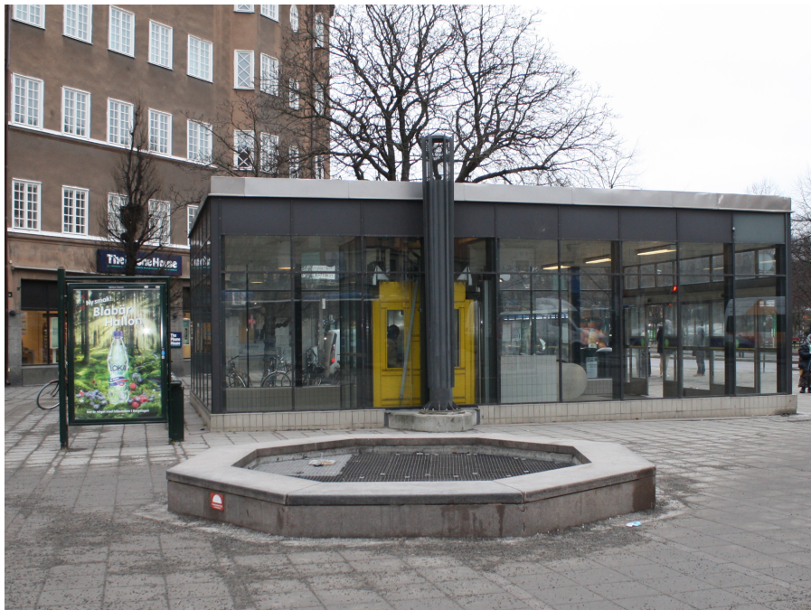
Exempel på ytanläggning för tryckutjämningschakt
