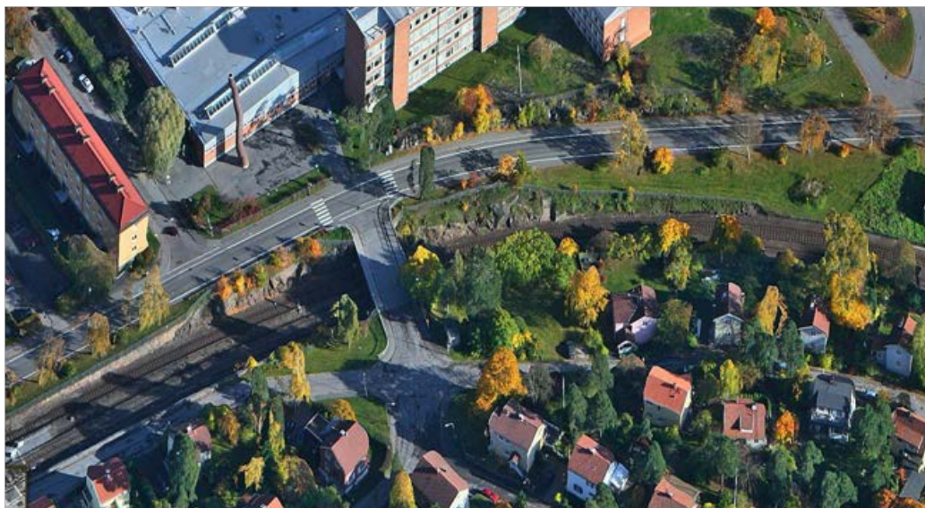
Figur 14. Befintlig bergskärning vid Odelbergsviadukten.
