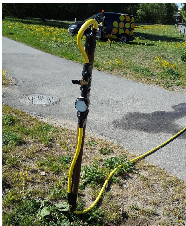
Figur 1. Observationsrör 14BE106 i vilket infiltration utfördes
