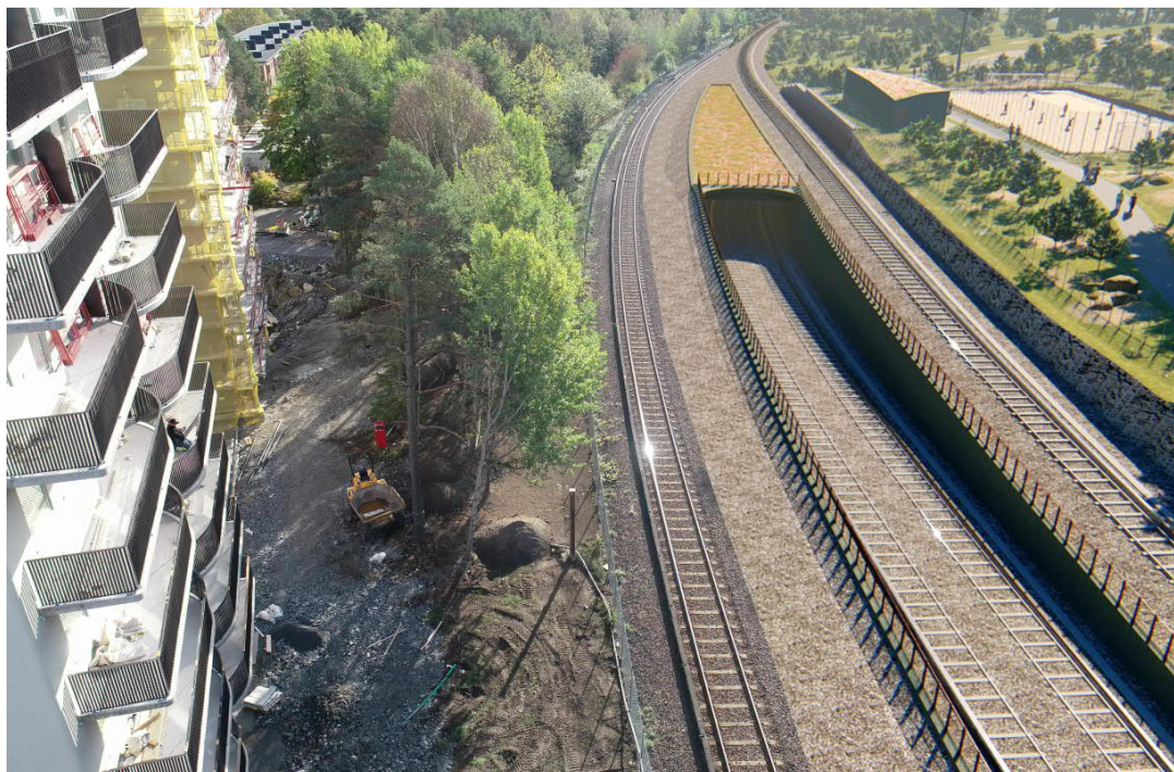
Figur 11. Flygvy mot söder, de nya anslutningsspår till Farstagrenen med tunnelmynning och tråg.
