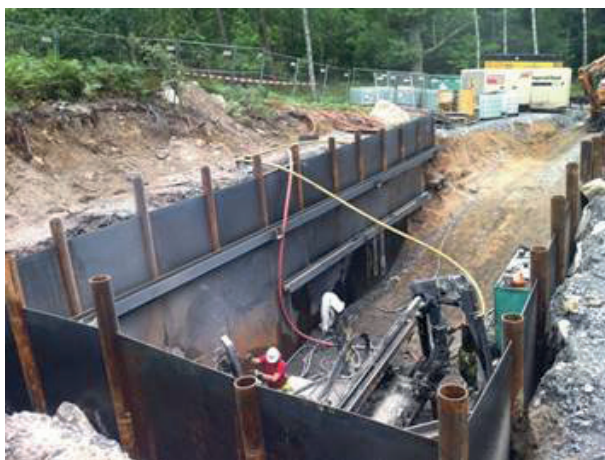
Figur 6. Bild till vänster visar borrarbete och bild till höger visar tätspons med förankringsnivå.
