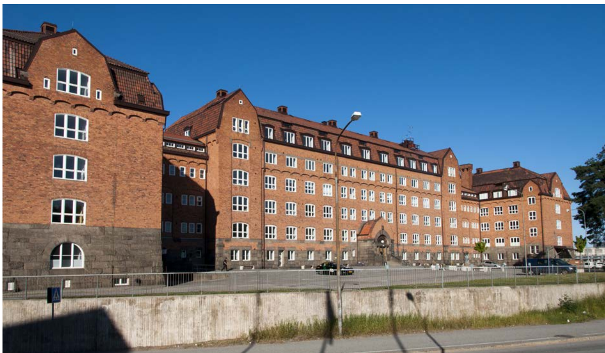
Figur 26. Byggnadsminnet SJ, Kontrollkontoret. Källa: RAÄ:s bebyggelseregister, 2013.
