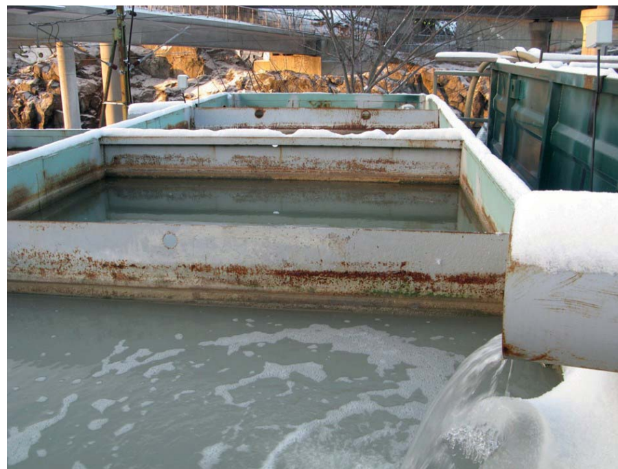
Figur 9. Exempel på sedimenteringscontainer, som använts vid utbyggnationen av Citybanan.
