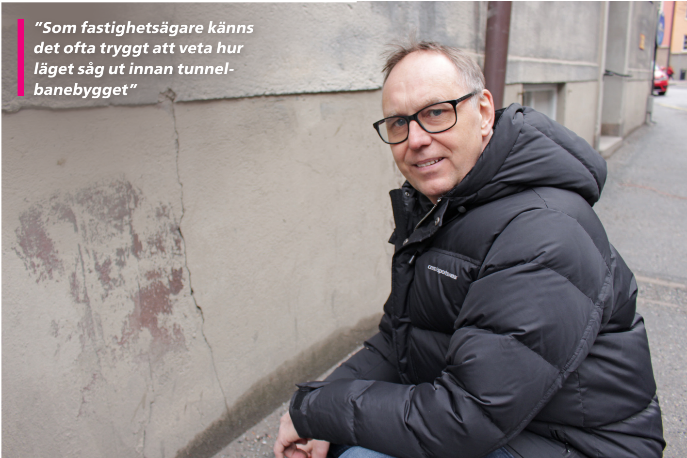
Innan vi börjar spränga för tunnlar ska alla byggnader i närheten besiktas. Kent Kling projektleder det arbetet.
