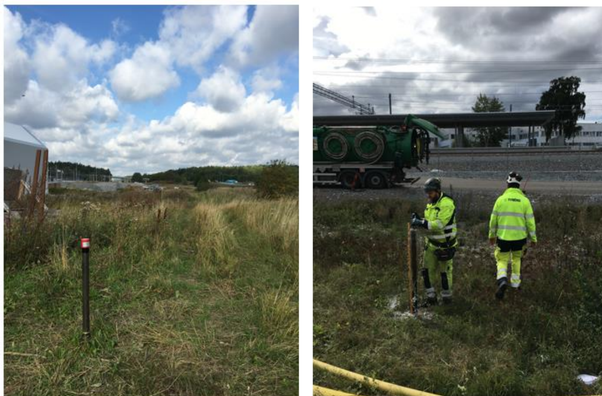
Figur 1. Till vänster ses grundvattenrör 17RT128G i vilket infiltration utfördes i och till höger ses utförandet av spolning inför utförandet av ett constant headtest.
