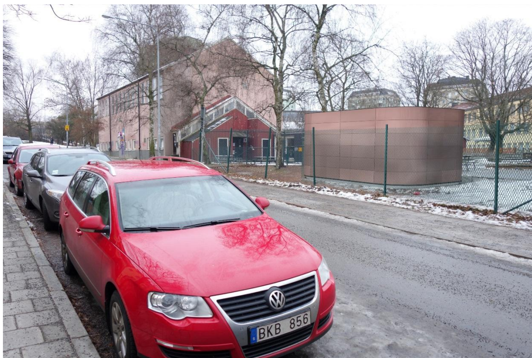
Figur 47. Brandgasschakt vid Klövervägen.
