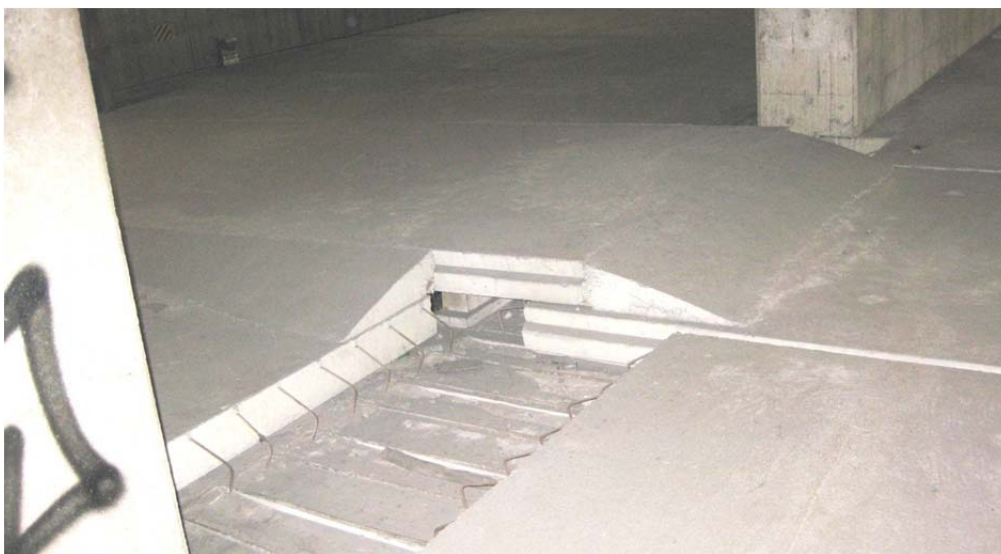
Två plattformselement indragna och lagda omlott.
