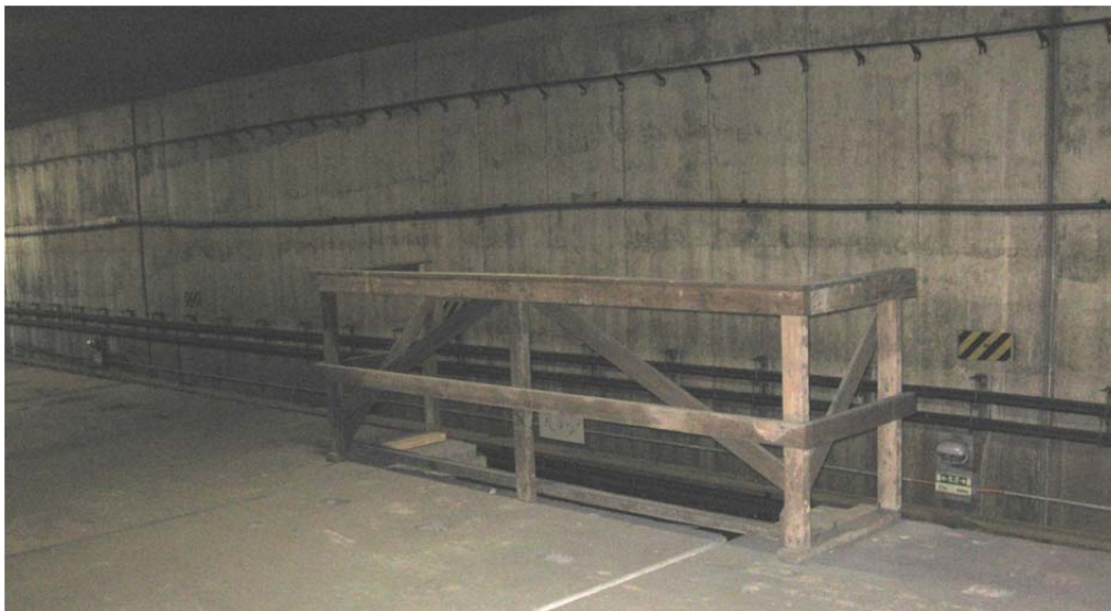
Skyddsnisch där plattformselementet är indraget mot mitten av plattformen.
