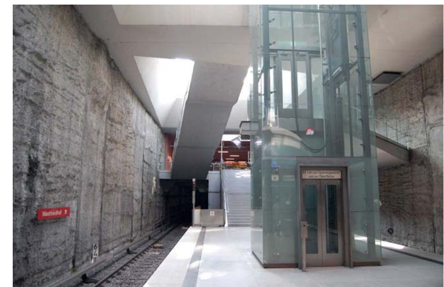
Plattformsrumsrum med dagsljus via ytor för vertikal-kommunikation, Westfriedhof. München
