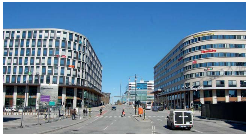
Framtida uppgång planeras i den vänstra byggnaden i bilden
