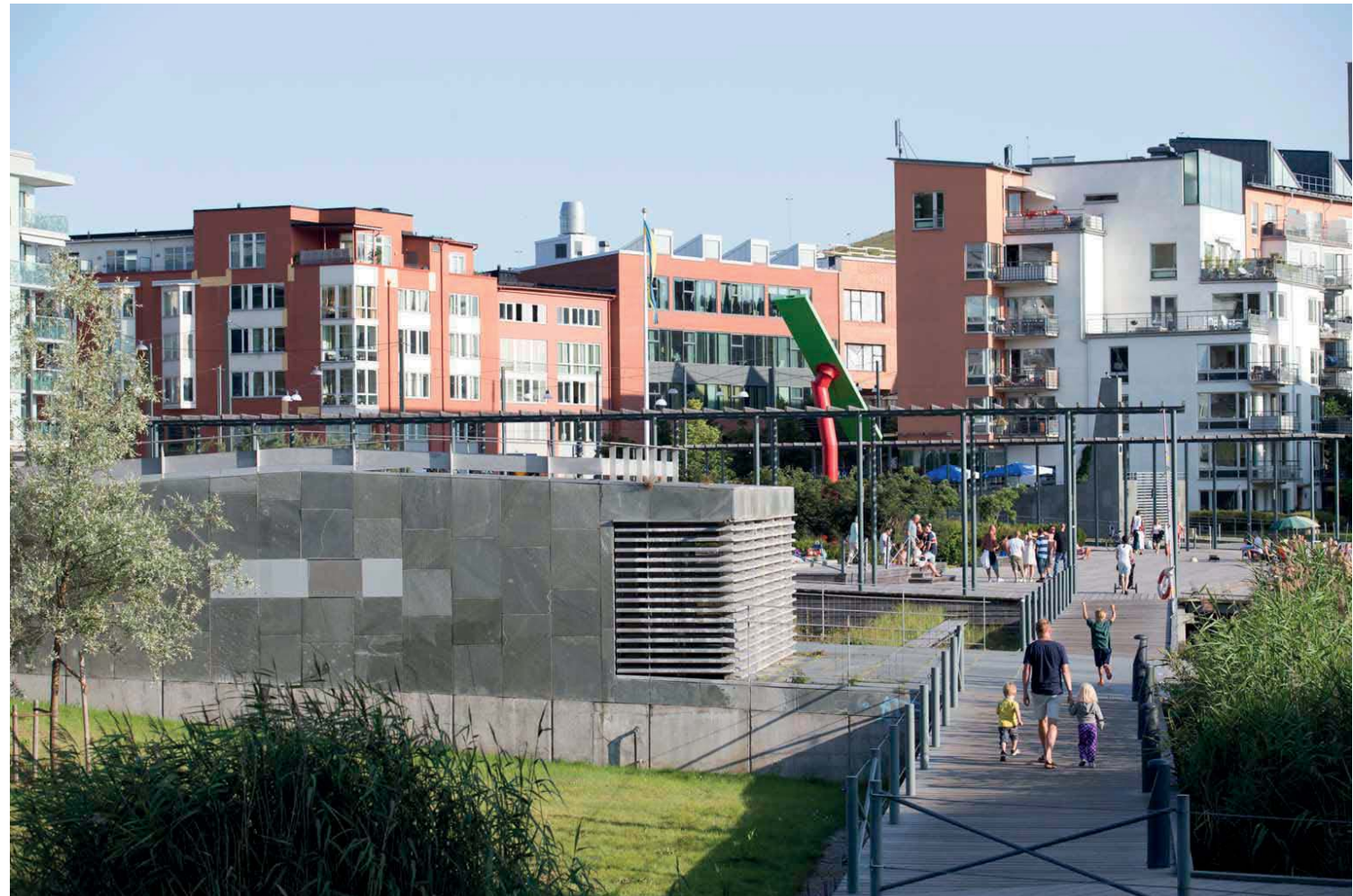
Teknikbyggnad integrerad i omkringliggande miljö
